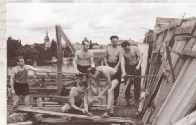
Wiederaufbau des Schuppens 1962
