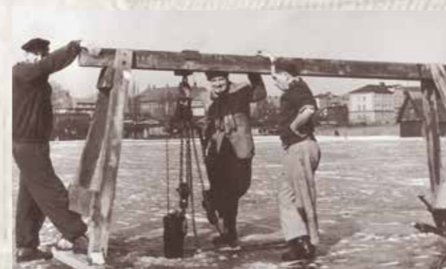
Pfahlarbeiten in den 90er Jahren
