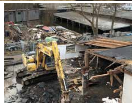
So sah es beim Abriss aus
