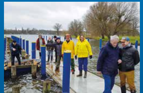
Sanierung des Gästegrabensteges am Südufer
