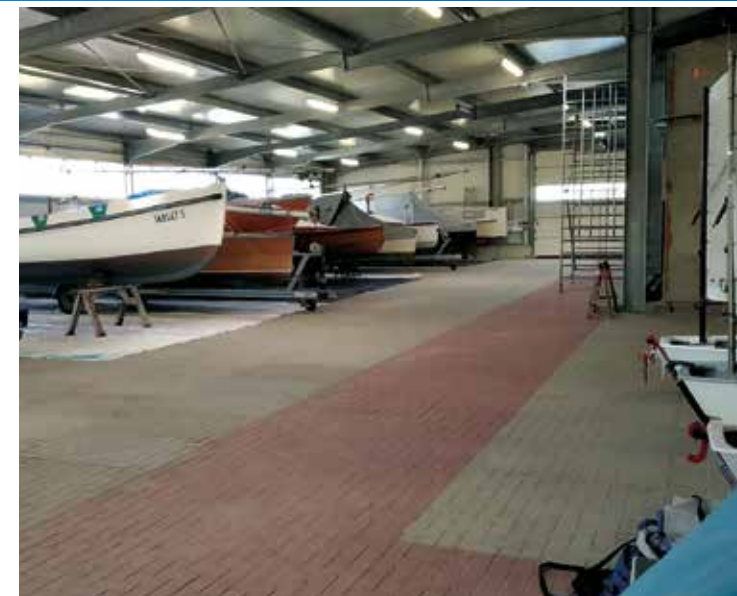
Innenansicht der neuen Halle
