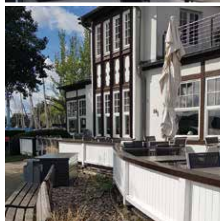
Fassade Seglerheim Brüstung Terrasse
