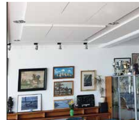
Neue Dämmung Klubraum
