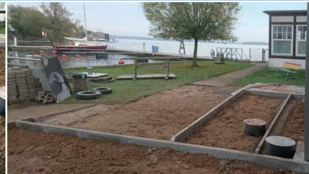
Beim setzen der Bordsteine
