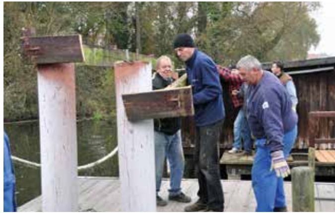
Beim Bau der Kamelbrücke 2012
