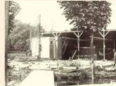
Abriss des alten Bootshauses im Sommer 1924
