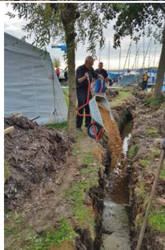
Bau der Saugwasserleitung 2018
