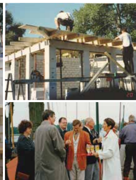
Bau des Sanitärtempels
