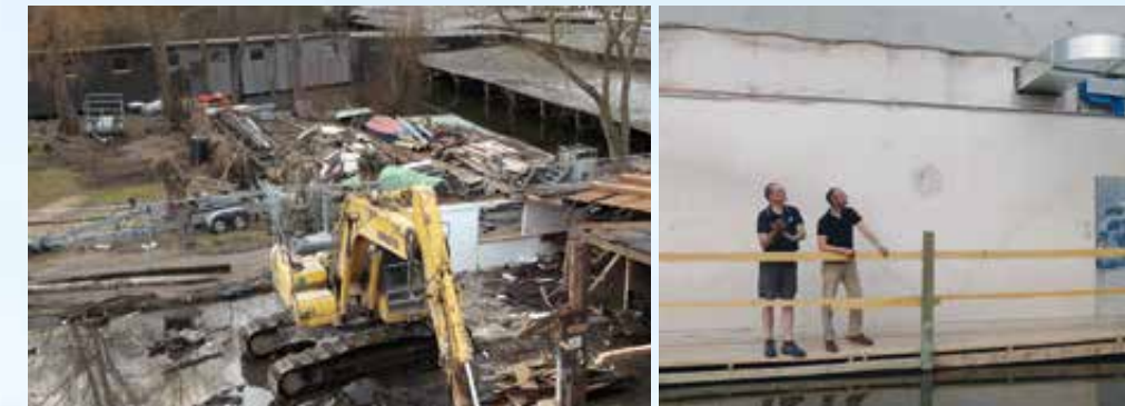
Abriss der alten Bootshalle
