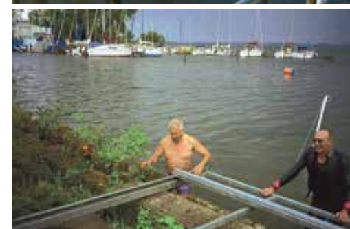
Aufbereiten von Rammpfählen 2005 Aufbau Slipanlage für die Segeltage 2004
