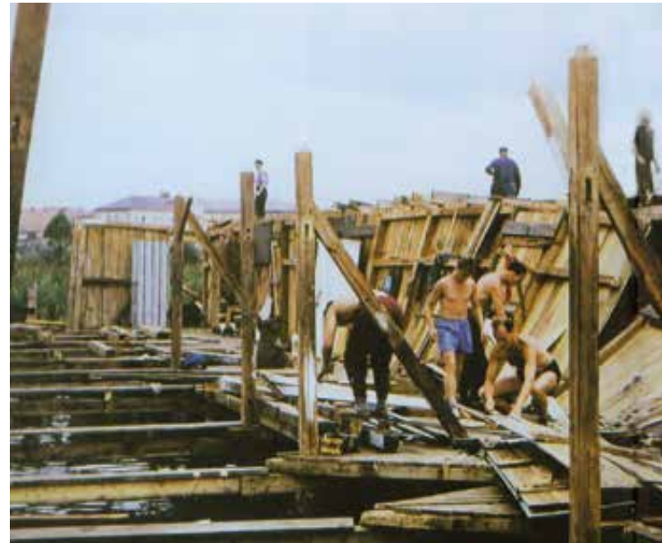
1959 Beseitigen von Sturmschäden
