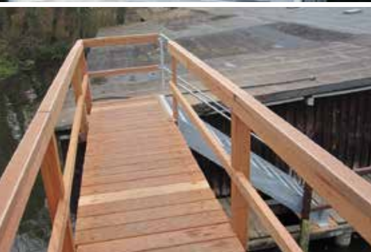
Alte Kamelbrücke mit Hühnerleiter aus den 60igern (oben) Neue Kamelbrücke 2011 (unten)
