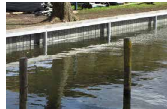
Der neue Übersetzerschuppen von 2012 (oben) Erneuerung der Uferbefestigung von 2014 (Mitte und unten)
